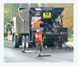
SLURRY SEAL – WEARING/ SEALING SURFACE
